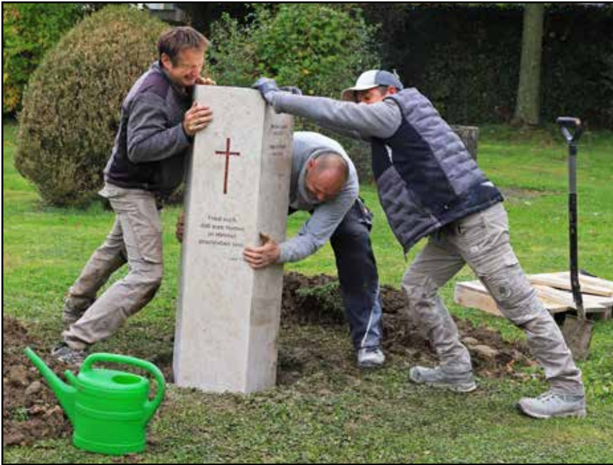
Die Handwerker bei der Arbeit. Die Stele aus heimischem Juramarmor erhielt nach dem Aufstellen noch eine Abdeckplatte mit Tropfnase, sodaß das Regenwasser der Oberseite nicht auf den langen Seiten nach unten läuft, sondern eben frei abtropft.
