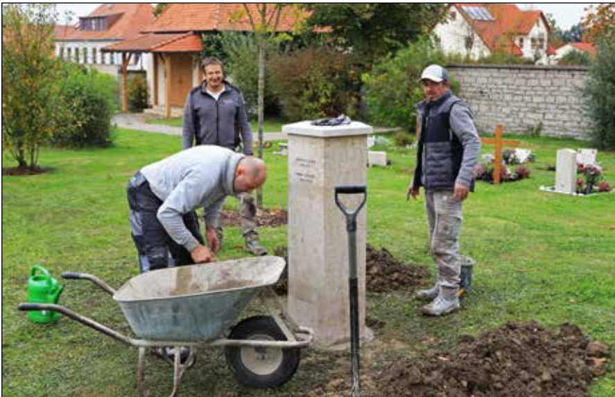
Die Handwerker bei der Arbeit. Die Stele aus heimischem Juramarmor erhielt nach dem Aufstellen noch eine Abdeckplatte mit Tropfnase, sodaß das Regenwasser der Oberseite nicht auf den langen Seiten nach unten läuft, sondern eben frei abtropft.
